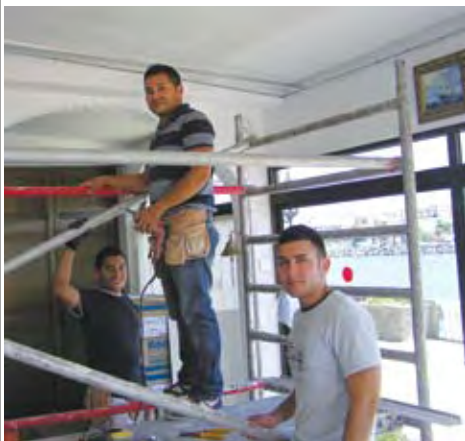
Montering av lydisolende takplater
